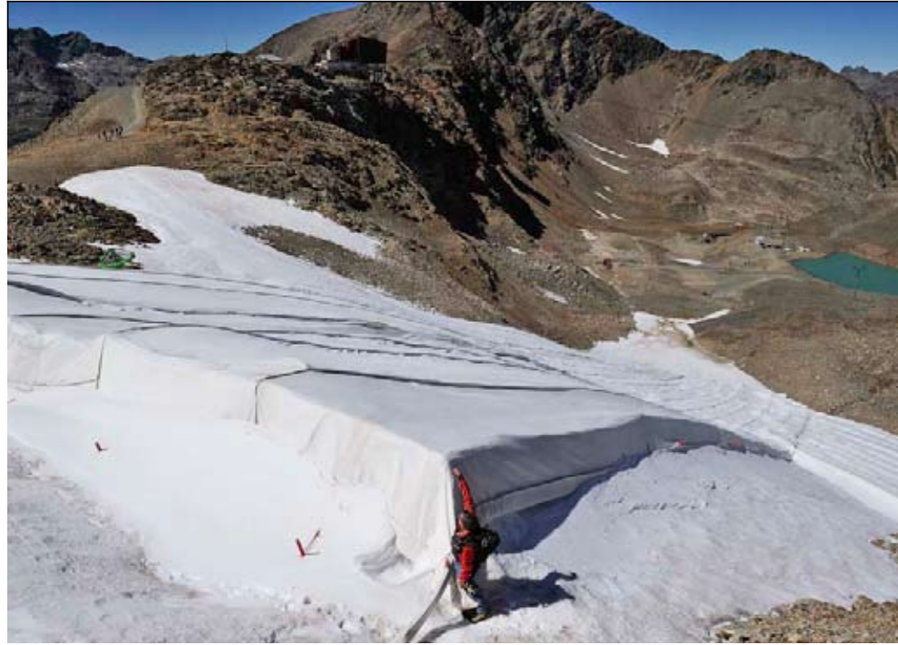
Der Effekt ist verblüffend: Die Abdeckung hat gut zwei Meter Schnee vor dem Schmelzen bewahrt
